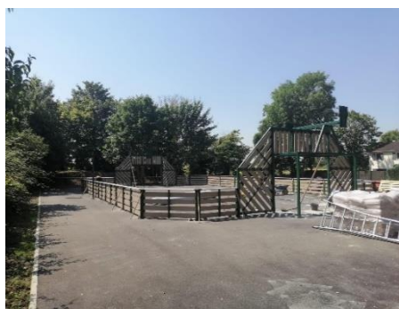
Toutes les barrières sont montées
